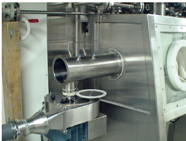
Figura. 24 - Dettaglio del sistema di filtrazione dell'aria espulsa e del relativo ventilatore che mantiene la depressione in un isolatore
